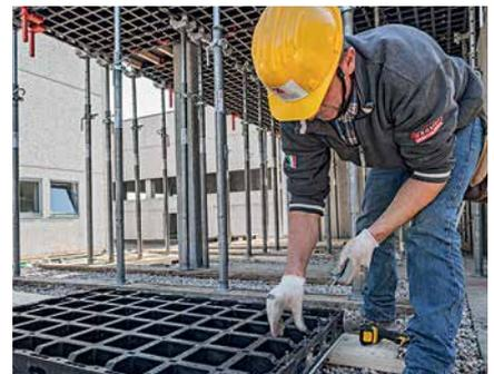
4. Закрепите новую обшивку опалубки с помощью винтов.
