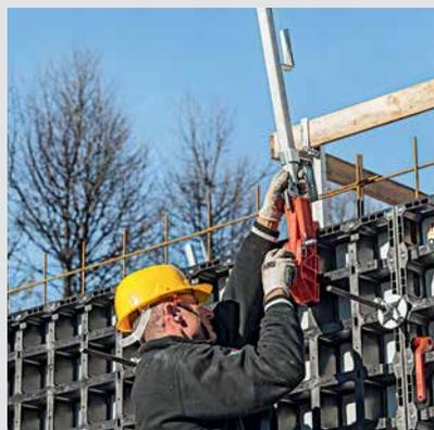
Безопасность на противоположной стороне опалубки обеспечивается за счет перил из трех конструктивных элементов и досок для торцевой защиты: адаптер подкосов DUO с дополнительным держателем стоек монтируется на панели; стойка перил просто вставляется.
