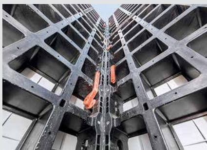
Прямые углы формируются бесступенчато. При необходимости использования доборных вставок, они устанавливаются между последней стеновой панелью и угловой панелью.
