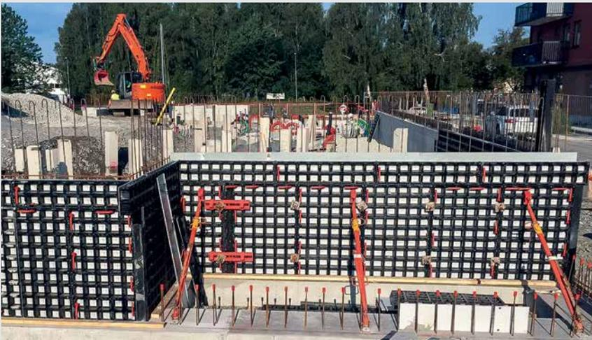
Сочетание панелей высотой 135 см и 0,60 м позволяет возводить стены высотой 2,55 м, 2,70 м и 3,30 м. Максимальное удобство при наращивании панелей по высоте достигается при использовании панелей шириной 15 см.
