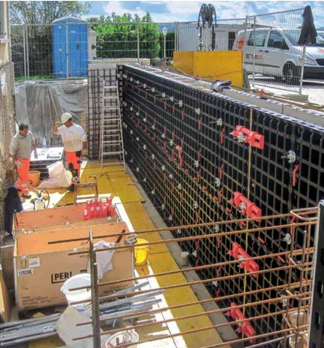
Система DUO стала идеальным решением для реконструкции и возведения пристройки без применения крана.
