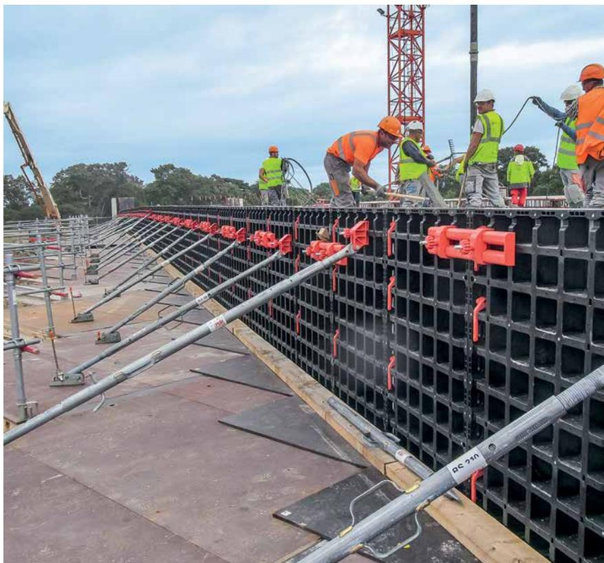
Панели DUO небольшого размера отличаются простотой монтажа и удобны для опалубливания фундаментов.
