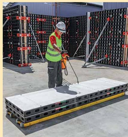
Рекомендуется использовать бетоноотделяющую жидкость PERI Plasto Clean, которая легко наносится с помощью пульверизатора.
