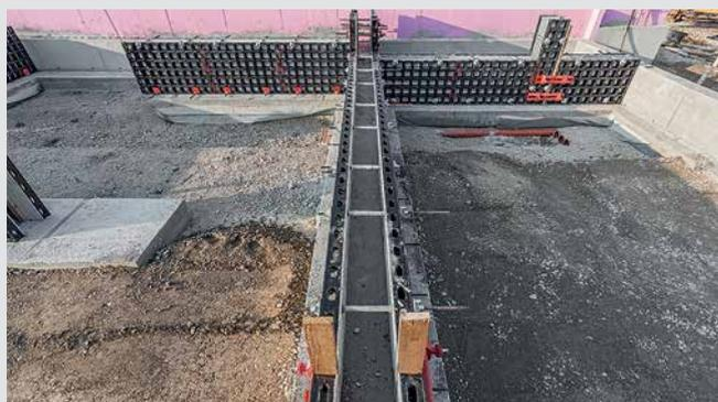
При выборе универсальных панелей также используются стандартные шайбы-гайки DW 15. Для фундамента со стандартными панелями используются кулачковые гайки, так как невозможно установить гайку-шайбу непосредственно над поверхностью земли.
