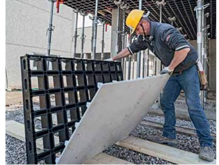
2. Удалите поврежденную обшивку опалубки.
