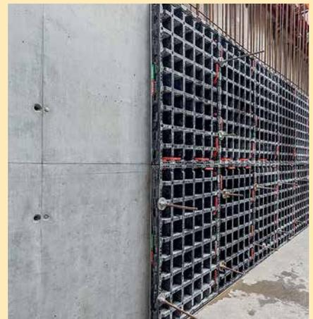
Обшивка опалубки не прилипает к бетону, что позволяет легко снимать панели при распалубке. В результате получается хорошее качество бетонной поверхности.
