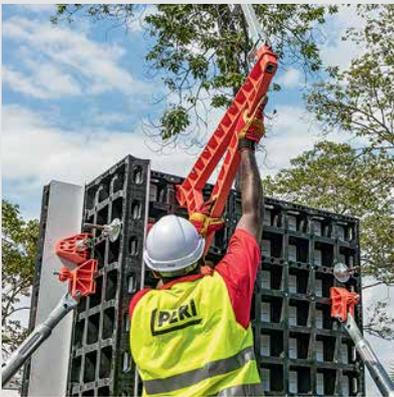
Стойки вставляются в кронштейн для крепления подмостей, а кронштейн крепится к панели. После этого монтируются настильные доски и доски для торцевой защиты, которые фиксируются с помощью винтов или гвоздей.
