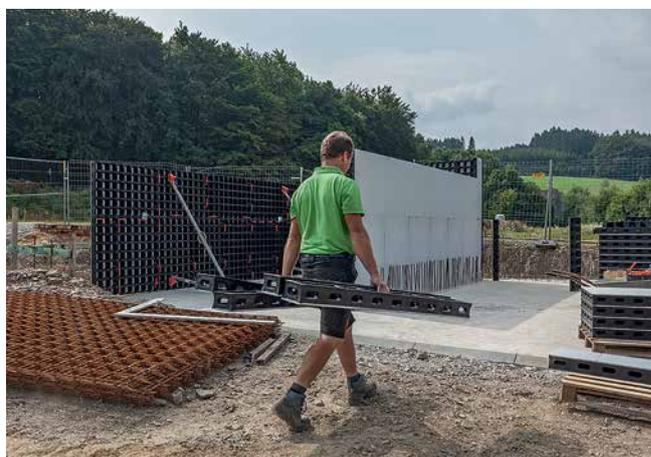
Монтаж системы DUO интуитивен и прост даже для строителей без опыта работы с опалубкой.
