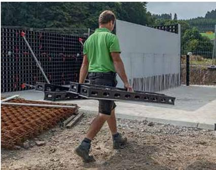
В панелях предусмотрены эргономичные отверстия для крепления соединителей. Данные отверстия также служат в качестве прорезей для захвата руками при перемещении элементов на строительной площадке.
