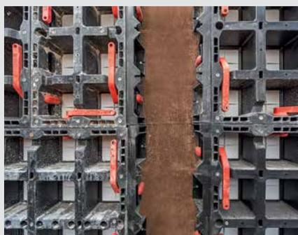
Накладка для фанеры крепится с помощью соединителей к сторонам панели и закрывается фанерой толщиной 18 мм. Таким образом, производится выравнивание при длине от 9 см до 25 см.
