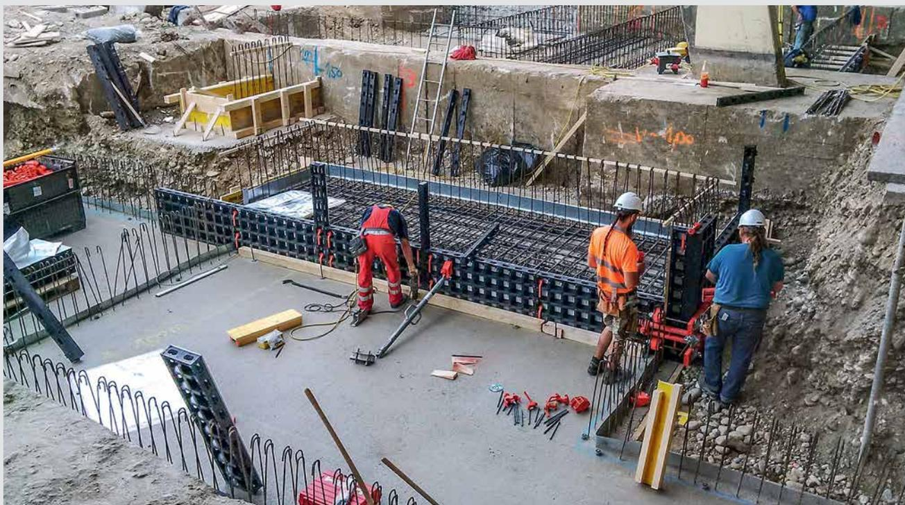
**Благодаря компактному формату и простому монтажу система DUO идеально подходит для опалубки фундаментов.**
