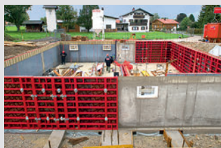
Стеновая опалубка
