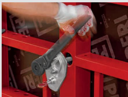
Закручивайте тяж MX с помощью специального ключа для тяжей MX, пока не станет возможно закрутить болт с проушиной.
