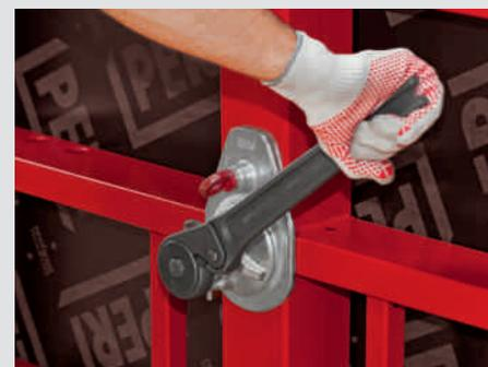
Затяните тяж MX с помощью специального ключа для тяжей MX до упора.
