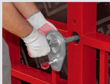
Вставьте тяж MX через отверстие в закрывающей опалубке в барашковую гайку первичной опалубки и закрутите.
