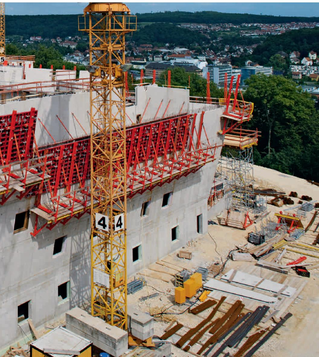
Помимо возможности универсального и экономичного применения при строительстве любых проектов на строительной площадке, опалубка MAXIMO позволяет создавать видимые бетонные поверхности высокого качества благодаря умелому выбору размеров и расположению щитов.
