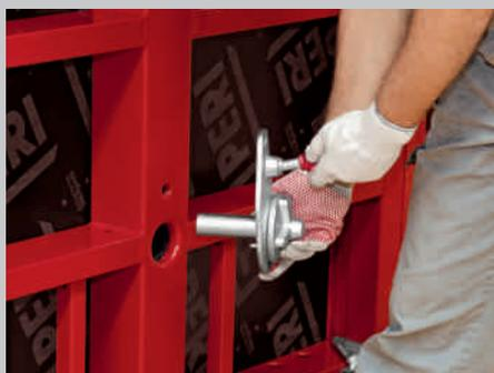
Установите шарнирную гайку MX на первичную опалубку и затяните болт с помощью ключа для тяжей MX.
